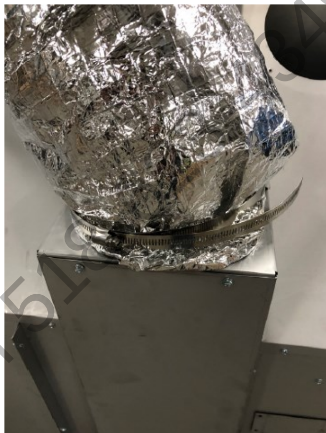
Figure 2.4, Installez le collier de serrage retenant l'isolant
