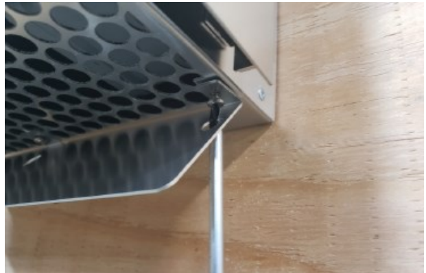
Figure 2.16 - Protecteur de revêtement de vinyle installé
